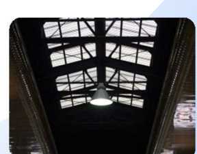
LED天吊照明
